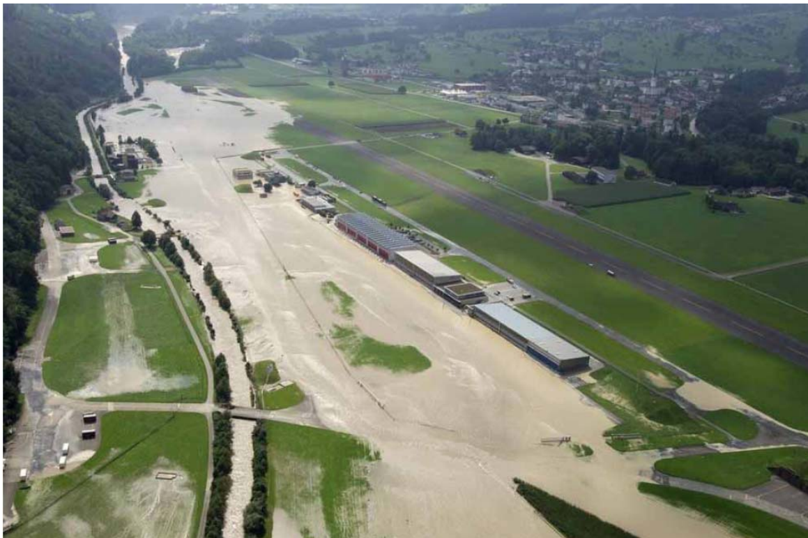
Überflutung Projektperimeter beim Hochwasser 2005
