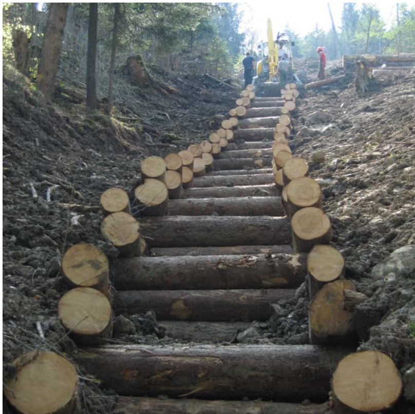
Einwandige Holzsperrn, Eichetschwand, 20.04.2007
