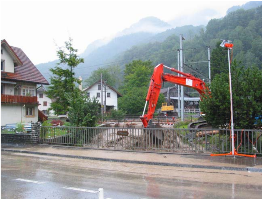
Abbildung 37: Brücke Kantonsstrasse und Eisenbahnbrücke über die Kleine Melchaa in Giswil.
