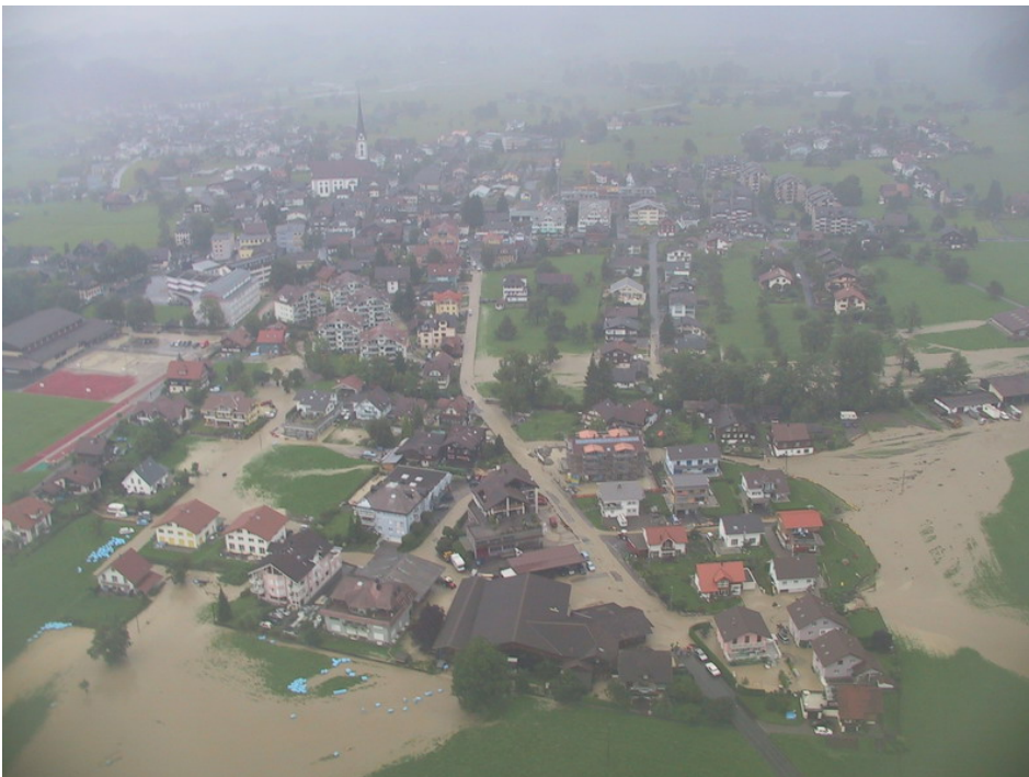
Abbildung 44: Überschwemmungsflächen des Foribaches im Gebiet Chäli, Breiten, Dossen.
