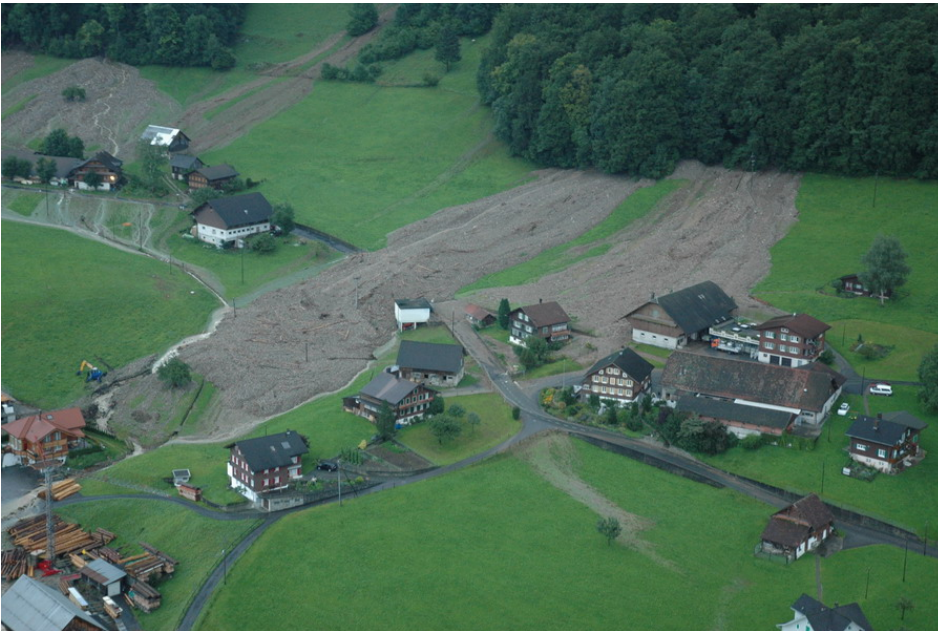
Abbildung 43: Murgangablagerungen des Lochgrabens in St. Niklausen.
