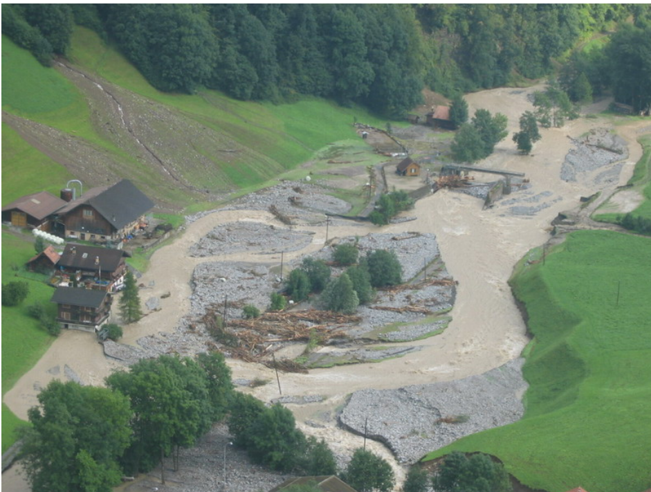
Abbildung 41: Grosse Melchaa im Gebiet Leh/Rismatt mit übersarter Wasserfassung des EWO.
