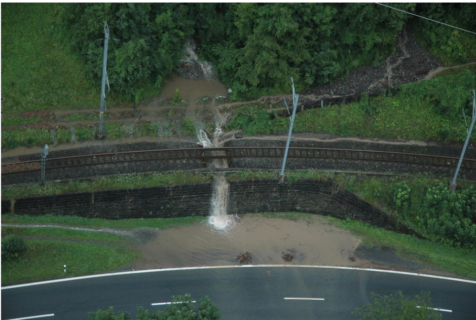
Abbildung 49: Schiessgraben bei der Zentralbahn und der Kantonsstrasse.
