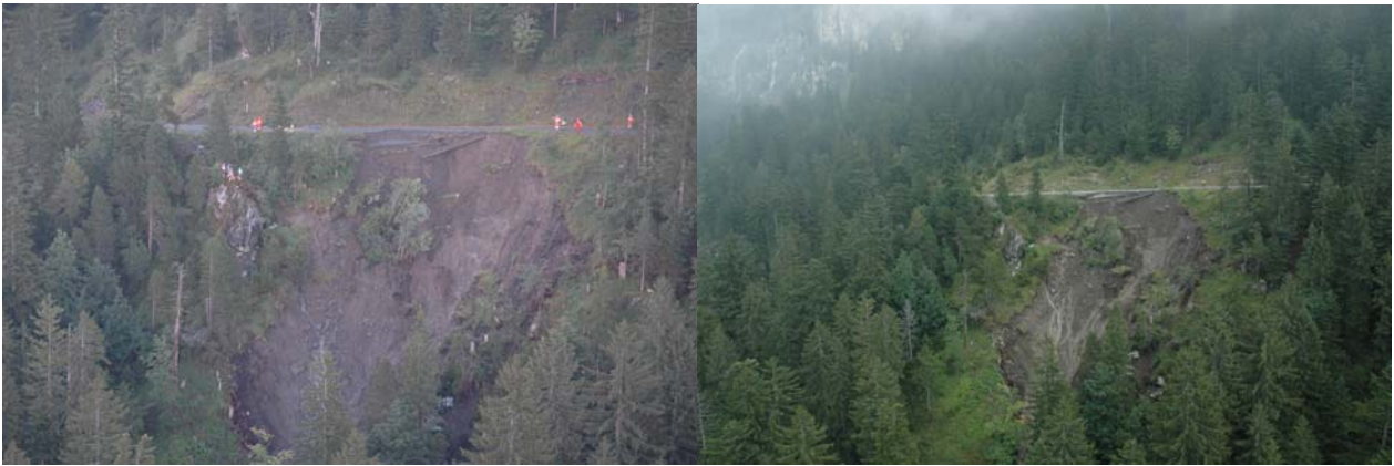
Abbildung 52: Rutschung Ochsenalp, Vorbereitung zur Sprengung des Grossblocks und Abflusskanal im Röhrlü.
