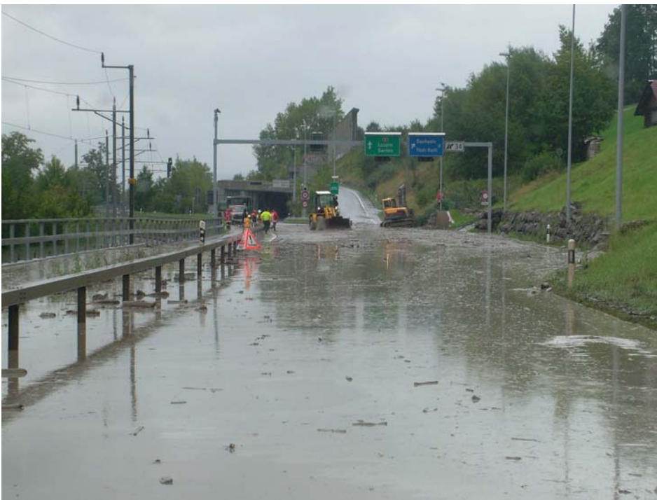
Abbildung 58: A8 vor dem südlichen Portal des Umfahrungstunnels Sachseln.
