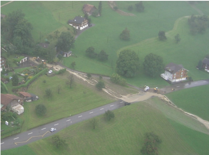
Abbildung 56: Schwerzbach bei der Flüelistrasse.
