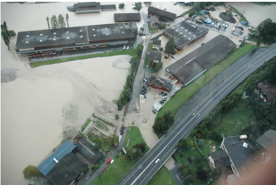
Abbildung 65: Ausbruchsstelle des Kernmattbaches unterhalb der A8
