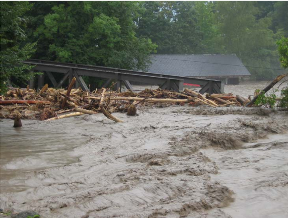
Abbildung 67: Grosse Melchaa mit ehemaliger Eisenbahnbrücke.
