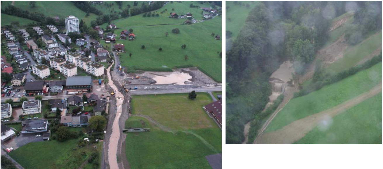
Abbildung 70: Bitzighoferbach mit unterbrochener Kantonsstrasse und Geschiebesammler Sackli.
